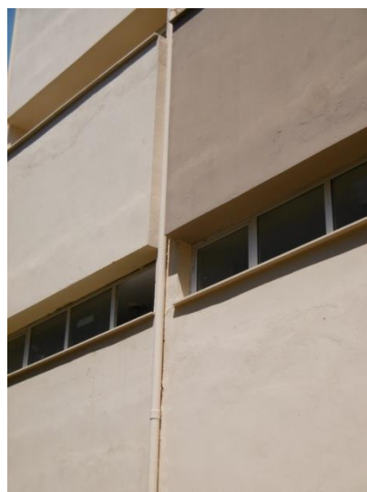
Φωτογραφία 2&3 : Δημιουργία κοντών υποστυλωμάτων στη δυτική πλευρά
