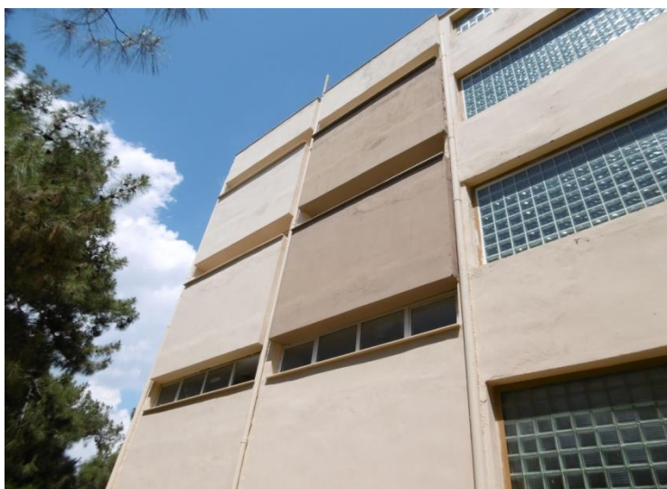
Φωτογραφία 2&3 : Δημιουργία κοντών υποστυλωμάτων στη δυτική πλευρά
