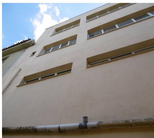
Φωτογραφία 4&5 : Δημιουργία κοντών υποστυλωμάτων στη βόρεια πλευρά
