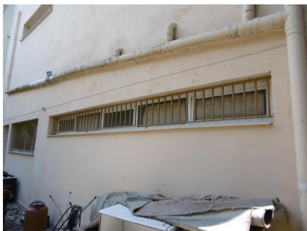
Φωτογραφία 4&5 : Δημιουργία κοντών υποστυλωμάτων στη βόρεια πλευρά
