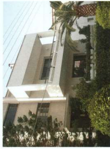
Κατά την διάρκεια και μετά την ενίσχυση κτιρίου με εφαρμογή της μεθόδου ΠΑΡΣΑΝΤ (Στην περίπτωση αυτή τα τοιχώματα ΠΑΡΣΑΝΤ χρησιμοποιήσαν για την προσθήκη εξωστών μήκους 3.5m)
