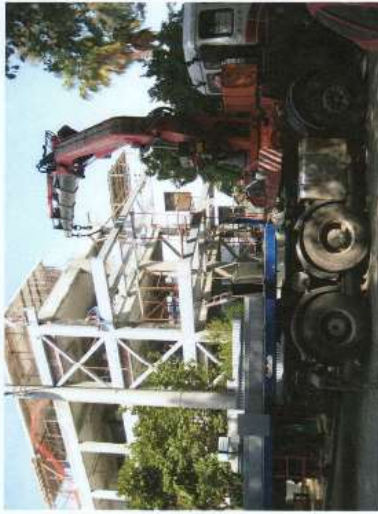
Κατά την διάρκεια και μετά την ενίσχυση κτιρίου με εφαρμογή της μεθόδου ΠΑΡΣΑΝΤ (Στην περίπτωση αυτή τα τοιχώματα ΠΑΡΣΑΝΤ χρησιμοποιήσαν για την προσθήκη εξωστών μήκους 3.5m)
