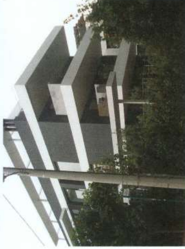
Κατά την διάρκεια και μετά την ενίσχυση κτιρίου με εφαρμογή της μεθόδου ΠΑΡΣΑΝΤ (Στην περίπτωση αυτή τα τοιχώματα ΠΑΡΣΑΝΤ χρησιμοποιήσαν για την προσθήκη εξωστών μήκους 3.5m)
