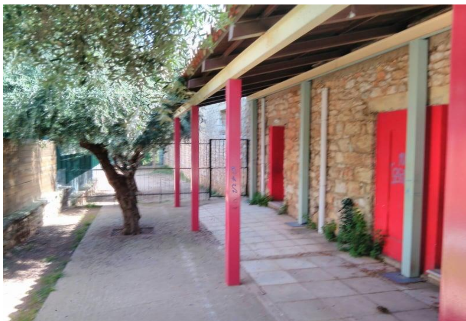
ΦΩΤΟ 4.5: ΠΙΣΩ ΟΨΗ ΤΟΥ ΠΑΛΑΙΟΥ ΚΤΙΡΙΟΥ (ΒΟΡΕΙΟΔΥΤΙΚΗ) – ΤΟΙΧΟΠΟΙΑ ΑΠΟ ΛΙΘΟΔΟΜΗ
