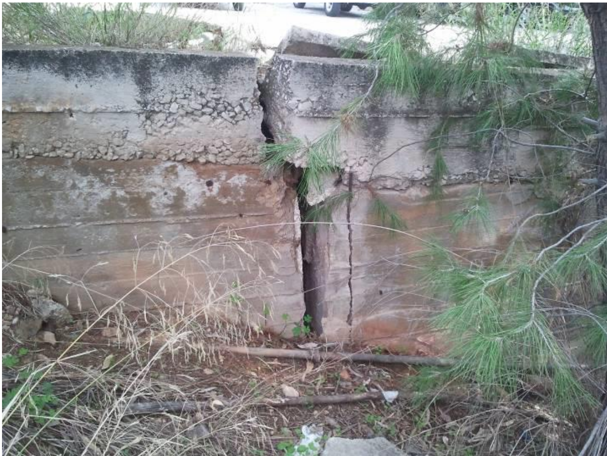
Φωτ. 2. Ενδείξεις μετακινήσεων σε αρμό του τοίχου αντιστήριξης
